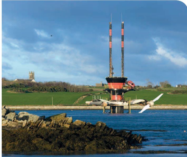
> Moderne Energiegewinnung aus Wasserkraft: „SeaGen“. Aus der 150 qm großen Strangford-Bucht im nordirischen County Down ragt ein schwarz-roter Stahlturm – das erste kommerzielle Gezeitenströmungskraftwerk der Welt
