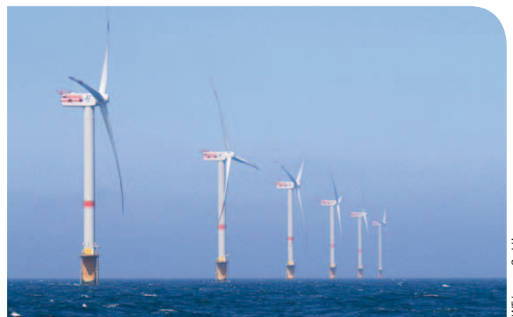
> Im Offshore-Windpark Thornton Bank wurden 6,15 MW-Windkraftanlagen von Repower SE errichtet
