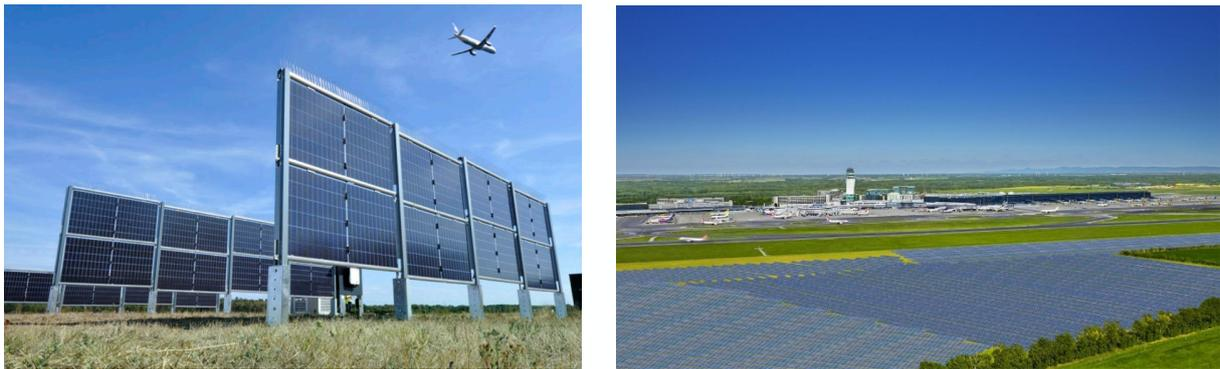
**Abbildung 9.10** Flughafen-PV. Senkrechte (links) und aufgeständerte Montage (rechts), Fotos: [81, 82]
