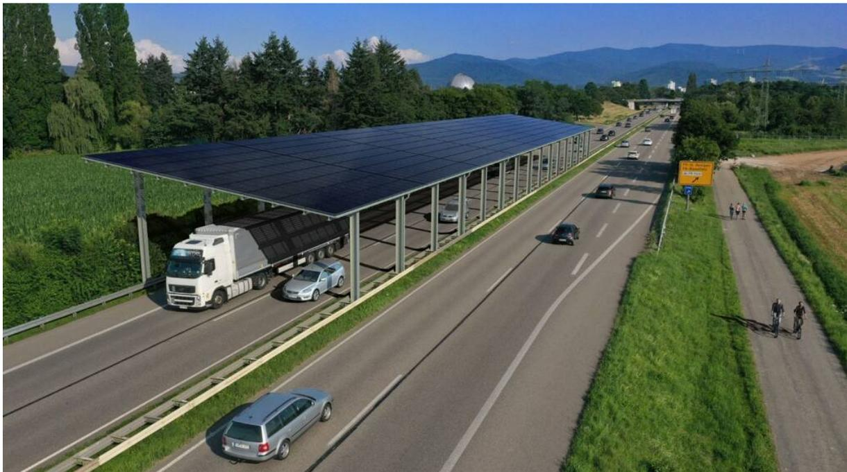
**Abbildung 9.6** Visualisierung einer Autobahnüberdachung mit RIPV, Foto: [74]
