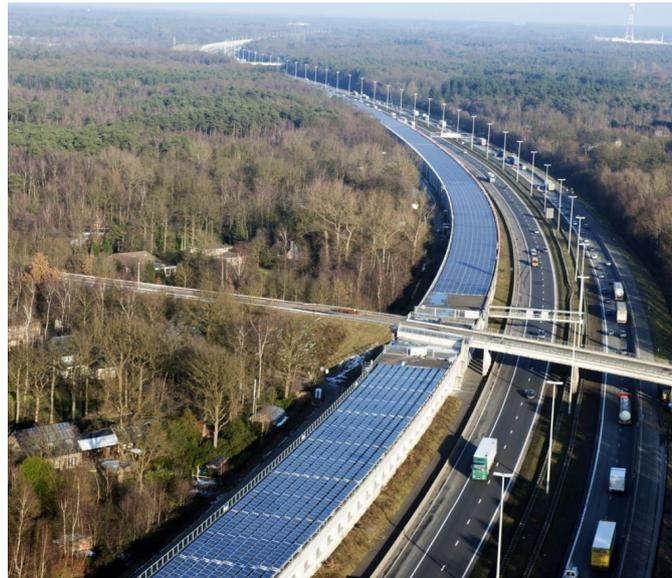
**Abbildung 9.8** Nachträglich installierte PV als oberer Abschluss einer Lärmschutzwand (links), *Solartunnel* in Belgien zum Schutz der Hochgeschwindigkeitsstrecke vor umstürzenden Bäumen, Fotos: [78, 79]
