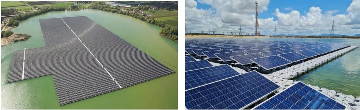
**Abbildung 9.12** FPV-Anlage auf stillgelegter Sandgrube (links); Detailaufnahme der Schwimmkörper und Aufständerung (rechts), Fotos : [85, 86]
