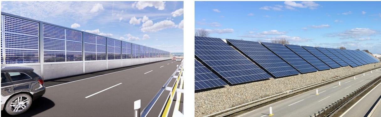
**Abbildung 9.7** Beispiele für RIPV als Lärmschutz. Semitransparente, bifaziale Autobahn-Lärmschutzwand (links) und monofaziale Böschungs-PV (rechts), Fotos: [75, 76]
