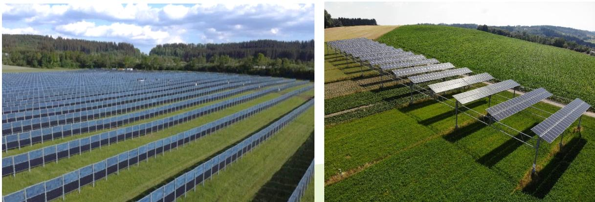
**Abbildung 4.16** Beispiele für vertikale (links) und hochaufgeständerte Agri-PV (rechts), Fotos: [37, 38]
