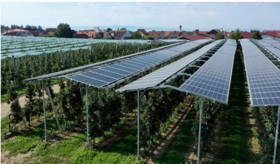
**Abbildung 4.19** Infobox zu Apfel-PV-Anlagen. Das Foto zeigt eine Gegenüberstellung zu herkömmlichen Schutzüberdachungen aus Plastikfolien. Foto: [60]
