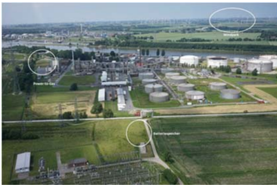
Innovatives Pilotprojekt: Sektorenübergreifender Ansatz im Multi-Megawatt Hybridspeicherprojekt in Brunsbüttel (Bild: Wind to Gas Energy)
